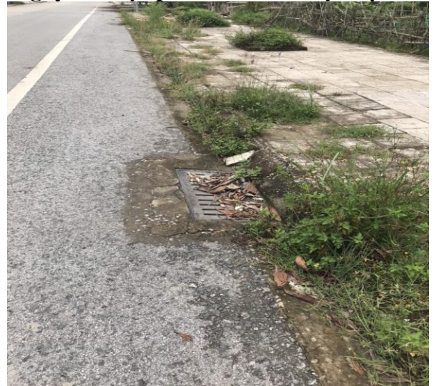
Hình 1.6. Hiện trạng thoát nước mưa phía Nam dự án
